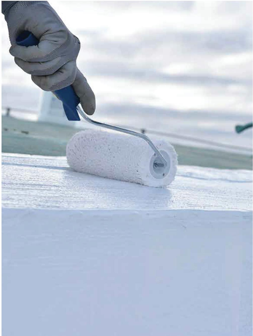
REVÊTEMENT MONO-COMPOSANT SOUPLE ET FLEXIBLE À BASE DE COPOLYMÈRES ACRYLIQUES PRÊT À L'EMPLOI POUR LES TRAVAUX D'ÉTANCHÉITÉ.
