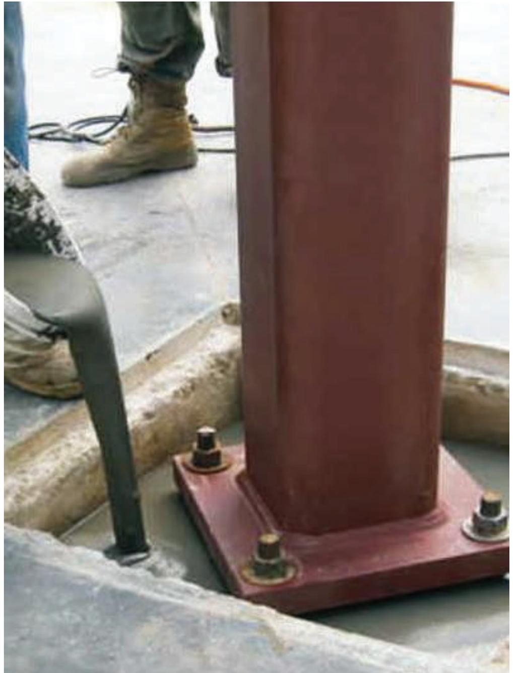
MORTIER DE SCELLEMENT ET DE CALAGE SANS RETRAIT DE HAUTES PERFORMANCES. EPAISSEUR JUSQU'AU 8CM.
