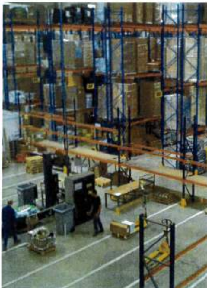
Couche d'usure à haute dureté pour les sols industriels soumis aux trafics sévères
